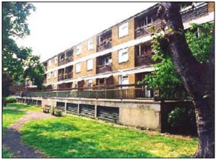
L'EDIFICIO "OWGAN ESTATE"
