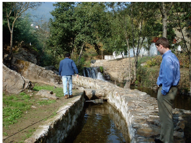
Restored mill leat at Mesão Frio , Rio Teixeira
