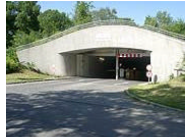
Parking souterrain de report modal situé à Mangfallplatz
