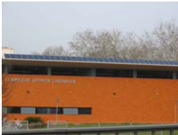
La mise en place de 60 m 2 de capteurs solaires thermiques sur le toit du Complexe Sportif du Lixenbuhl. Ils permettront d'éviter l'émission de 6 400 kg de CO 2 .
