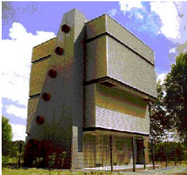
INSTALACJA KOGENERACYJNA W MIEJSCOWOŚCI ARNHEM
