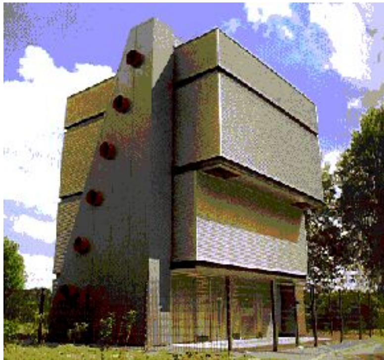
CENTRALE DE COGENERATION D'ARNHEM
