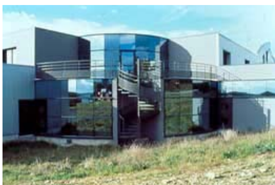
Maison des entreprises du COB à Carhaix
