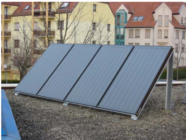
L'installation d'un brise-soleil photovoltaïque à l'Ecole Elémentaire des Vergers.
