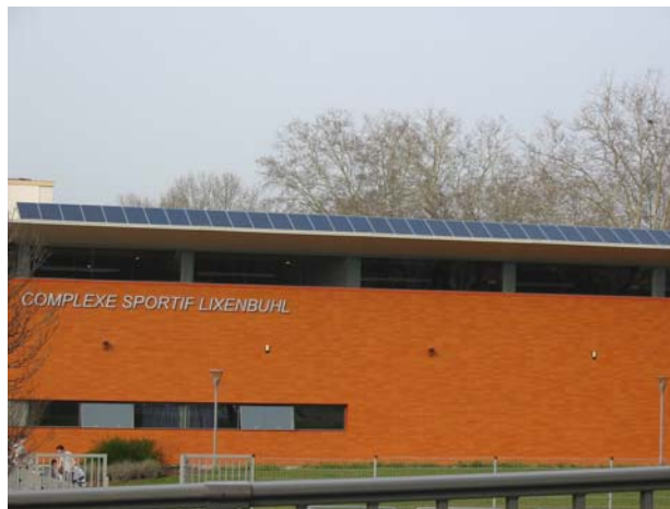
La mise en place de 60 m 2 de capteurs solaires thermiques sur le toit du Complexe Sportif du Lixenbuhl. Ils permettront d'éviter l'émission de 6 400 kg de CO 2 .
