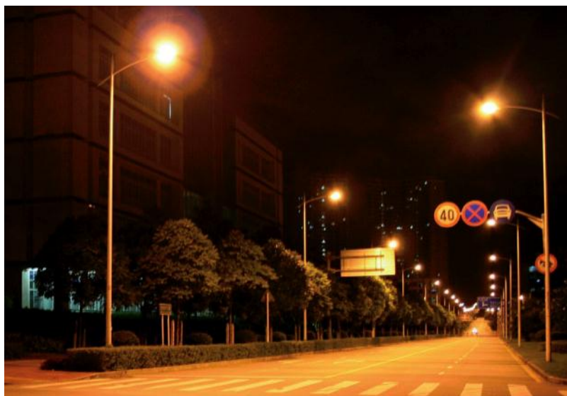
Avant : lampadaires à vapeur de sodium 250 W
